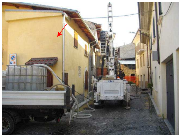
Aggregato edilizio in oggetto - Esecuzione sondaggio geognostico S1
