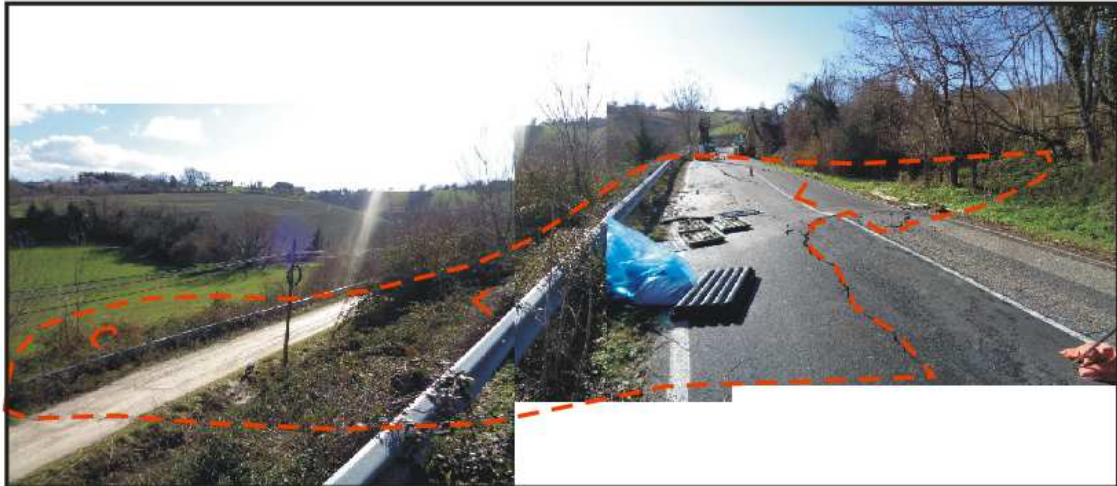
dissesto franoso ATTIVO in oggetto che ha vulnerato il tratto stradale in oggetto - vista da Nord-ovest
