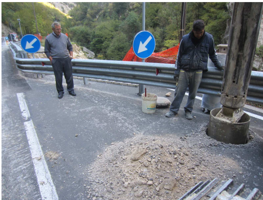
Realizzazione di un sondaggio geognostico a rotazione (ottobre 2014)
