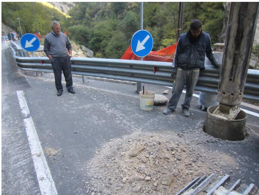
*Realizzazione di un sondaggio geognostico a rotazione (ottobre 2014)*
