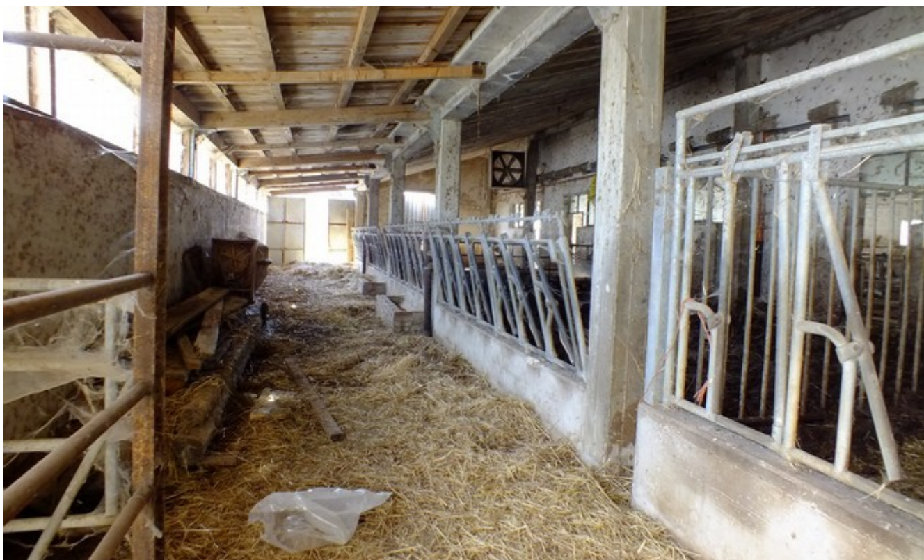
Settore della stalla destinato all'ingrasso largo circa 5,6 m di box e 3,3 di corsia (la corsia non è indicata nella planimetria catastale).
