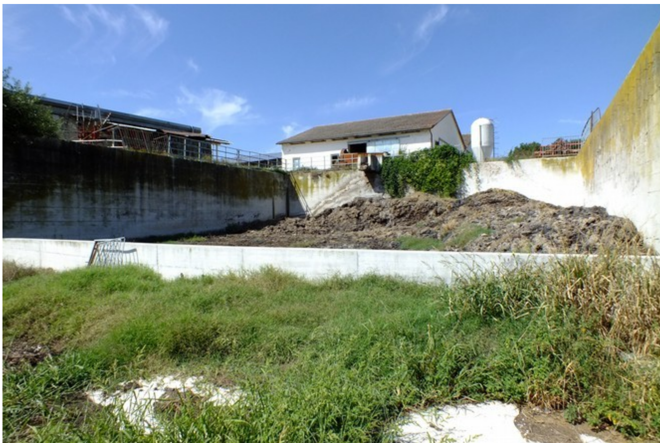
Letamaia delle dimensioni 18,5 m x 17 m x 4 m di altezza con pozzetti di raccolta liquame.
