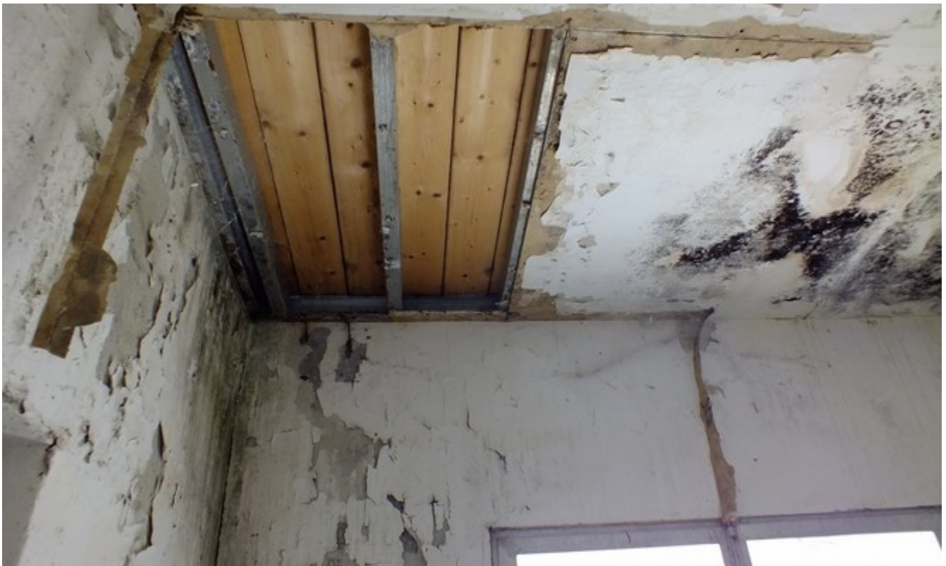
Ufficio della stalla con evidenti problemi di infiltrazione di acqua dalla tettoia,
