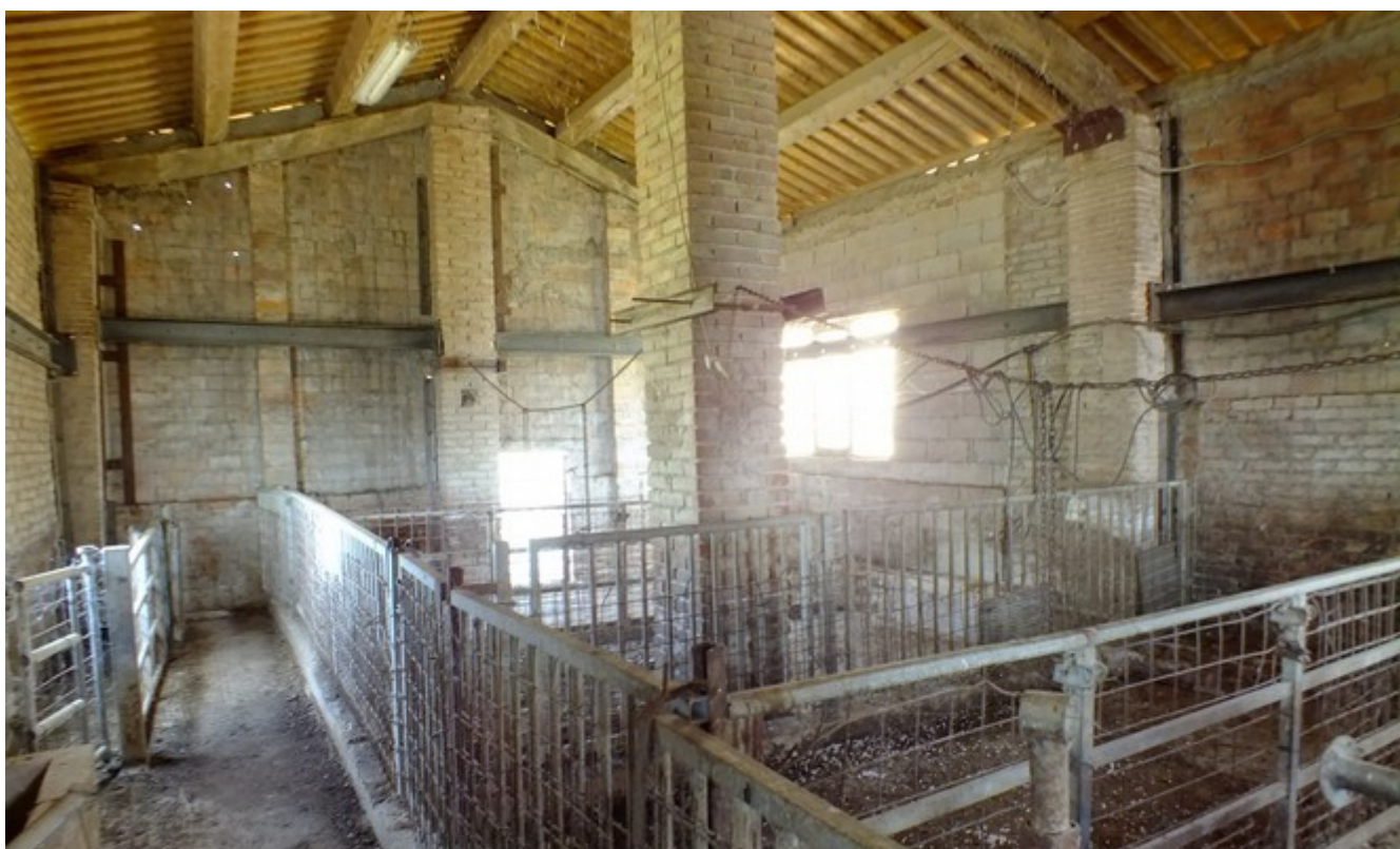
Interno della porcilaia: sono chiaramente visibili il tetto rifatto di recente in economia e il rinforzo strutturale con travi doppio T realizzato dal Comune.
