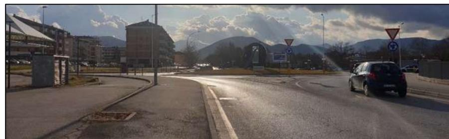
Verificata l'efficacia del percorso ciclabile sperimentale, come per le tratte precedenti l'**alternativa A** propone il consolidamento dello stesso attraverso l'ampliamento del marciapiede esistente lungo il lato sud della carreggiata e l'inserimento di un nuovo filare alberato lungo il lato sud della carreggiata per la riqualificazione generale dell'asse stradale e per ombreggiare il percorso ciclabile rendendone più piacevole la percorrenza.
