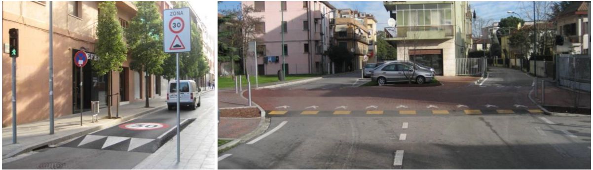
Figura 6-11. Esempi di interventi di moderazione del traffico nelle Zone 30
